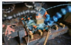
設備予兆監視
