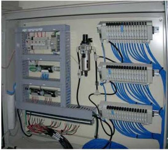
写真5 DeviceNet 対応の電磁弁ユニット
