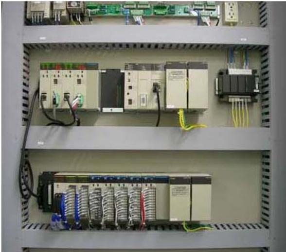
写真2 監視室内の盤内に収納されている“PLC計装”機器（オムロン製CS1D）
