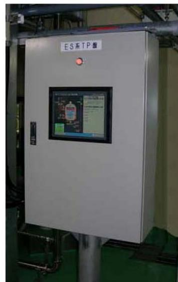
写真4 製造装置脇に設置されているタッチパネル操作盤
