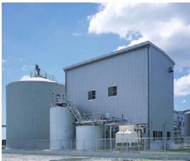
写真1 アルカリ水素メタン発酵実証プラント
