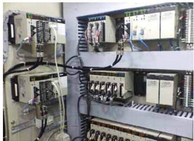
写真3 制御盤内のガスタービン制御専用通信ゲートウェイ (左側の2台) : 上がアクティブ機、下がスタンバイ機
