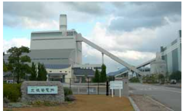
写真 1 中国電力 三隅発電所
