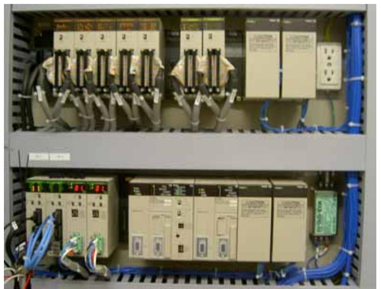
(写真 3 計装盤内部(全体)と PLC の配置状況(CPU は二重化))
