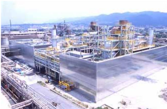
宇治事業所内に、ガスタービンを用いた大型電源コジェネレーション設備を建設し、宇治エネルギーセンター（写真1）として操業を始めた。この設備では、硫酸化物の発生がない都市ガス（天然ガス）を燃料とし、宇治事業所へ蒸気と電力を供給している。加えて、余剰電力を特定規模電気事業者を通して需要家へ供給することによって、エネルギー効率を約90%に高めることができた。
