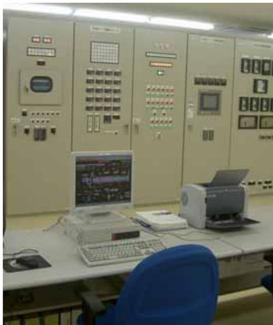
監視・操作用として、複数の HMI を設置し、それぞれ独立した HMI ソフトを動作させている。そのため、万が一、1 台の HMI にトラブルが発生しても、他の HMI で操作・監視を継続できる。
