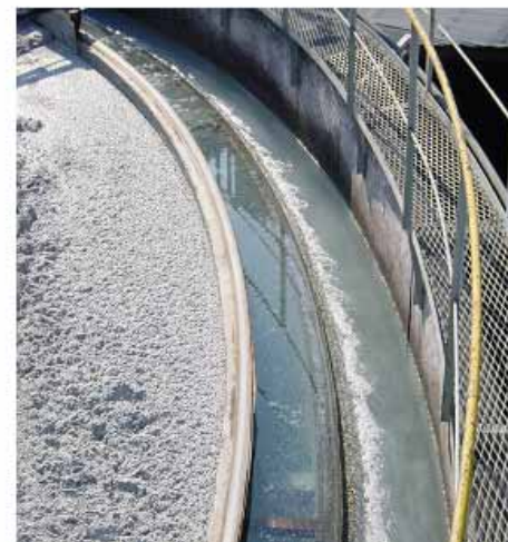
排水処理設備クリフロータ (栗田工業製)まわり
