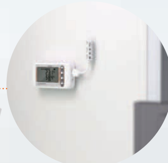
クリーンルーム内の 温湿度常時計測 温湿度ステーション
